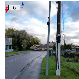
Rue du Moulin D16B
