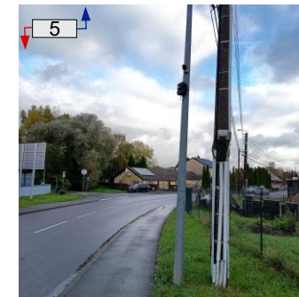
Rue du Moulin D16B
